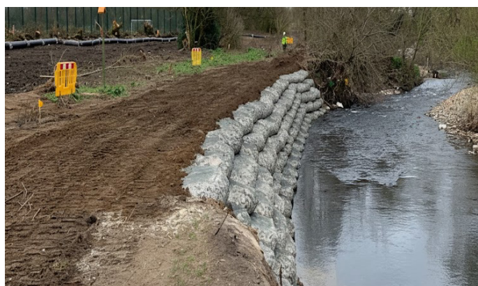
Exempel på hur rockbags kan agera motvikt och skydda slänter från erosion och skred.
