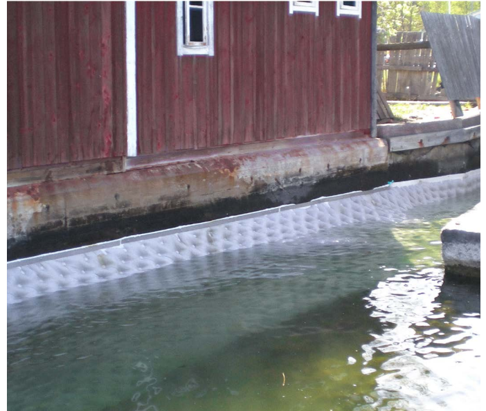
Bild: Tecomatic Yxlans färjeläge, Köpmanholm, där erosionsskyddet tillåter att den gamla byggnaden bevaras.
