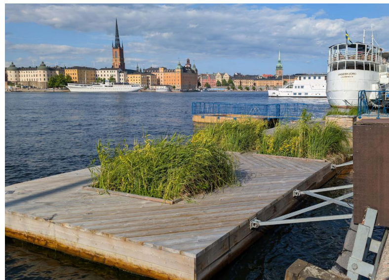
Bild: Tecomatic Kajbalkong vid Söder Mälarstrand i Stockholm.
