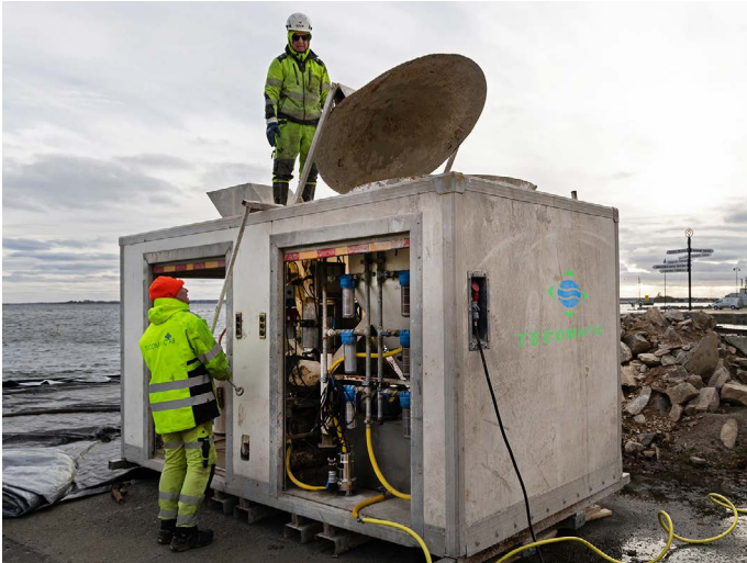
Bild: Tecomatic, fotograf Joachim Grusell. Tillverkning av lättbetong vid renoveringen av Kungsbrokajen i Karlskrona.
